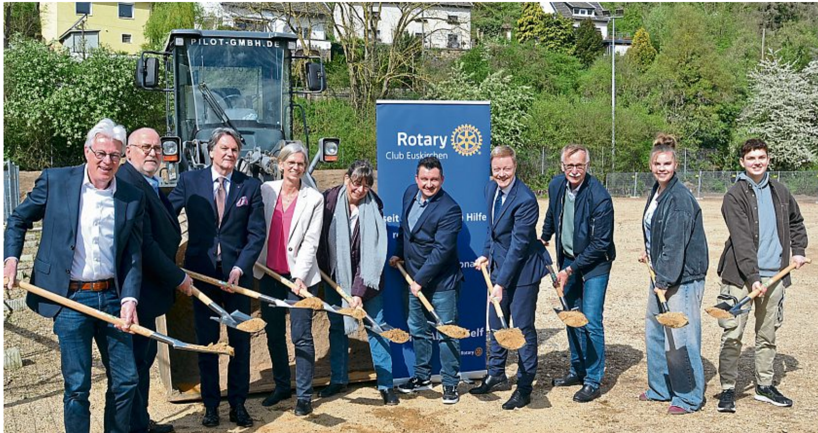
Dank der Spenden beider Euskirchener Rotary-Distrikte sowie zahlreicher weiterer Unterstützung konnte am Dienstag der erste Spatenstich für die neue St.-Angela-Sportanlage vollzogen werden. Foto: Cedric Arndt
